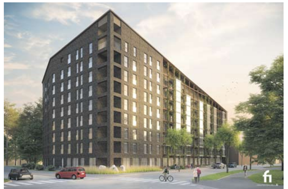
Uusi talo sijaitsee Ailakinkadun ja Rusokinkadun kulmassa. Kuva: KOAS / JASO
