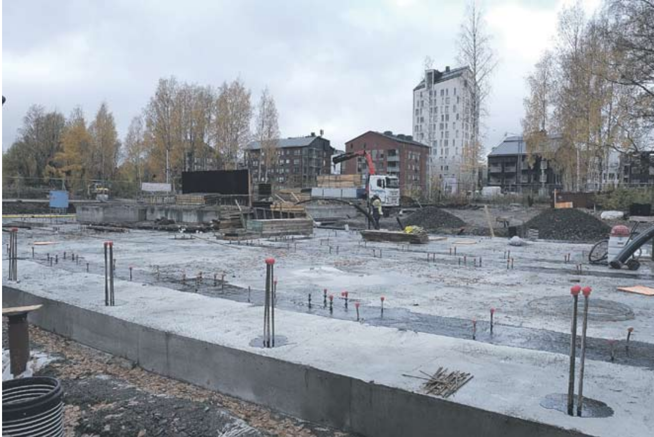
Perustustyöt rakennuksella etenevät nopeasti. Kuva: Tony Melville
