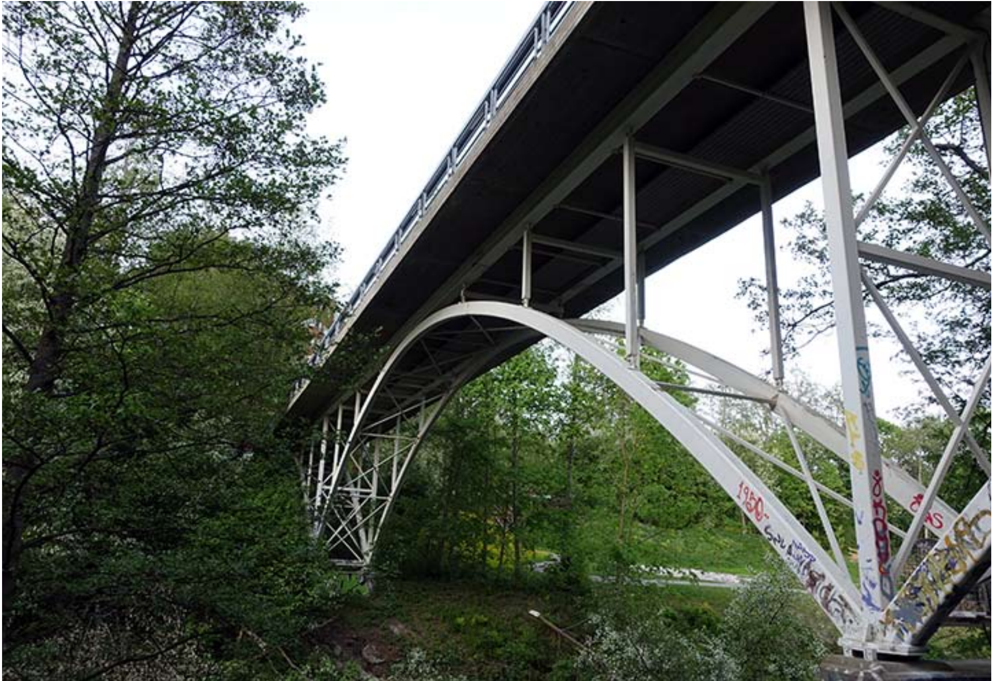
Kinakujan silta ylittää Tourujoen varsin korkealta. Kinakujan sillan leventäminen kenties riittäisi eikä uutta siltaa tarvittaisi.
