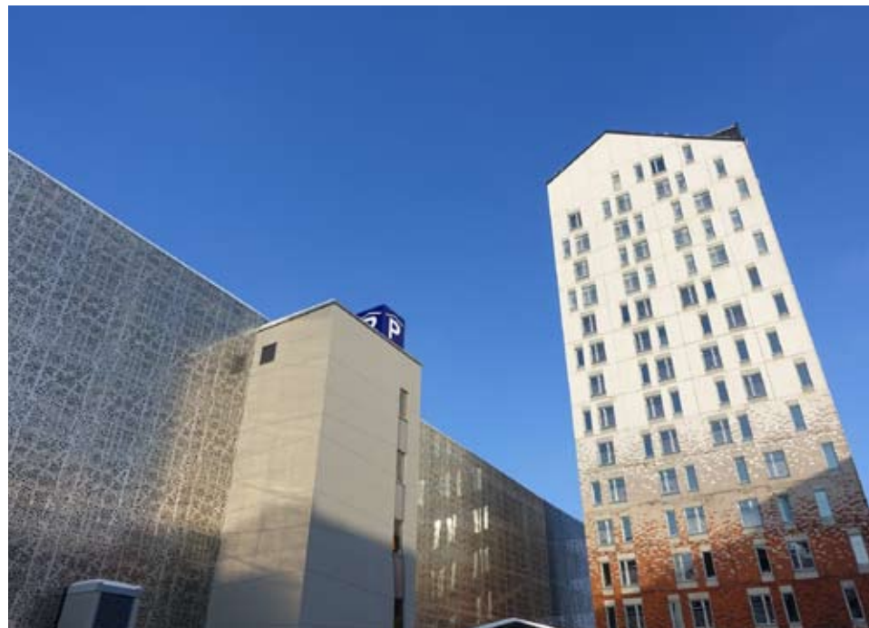
Kankaan pysäköintitalossa P-Pergamentissa on yhteensä seitsemän kerrosta, joista viisi on maan päällä ja kaksi kerroksista sijaitsee maan alla. P-Pergamentissa on käytettävissä 622 pysäköintipaikkaa. Kuva: Tony Melville.
